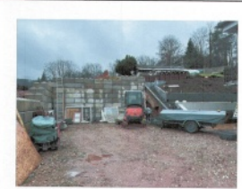
SCHWERLASTMAUER VON NORDEN
