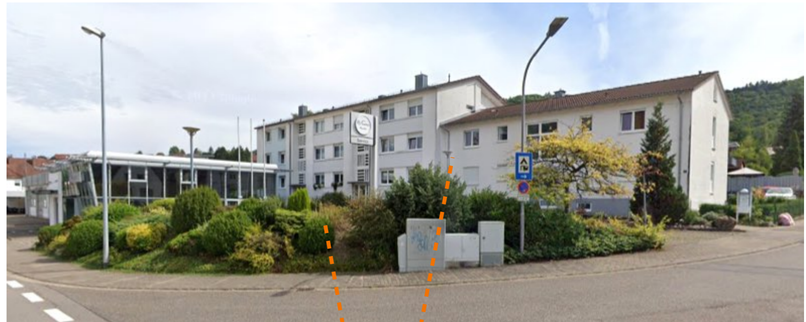
Blick Landauer Str. / Burgenring auf Flurst. 1753/10 mit Rückwärtigem MFH
