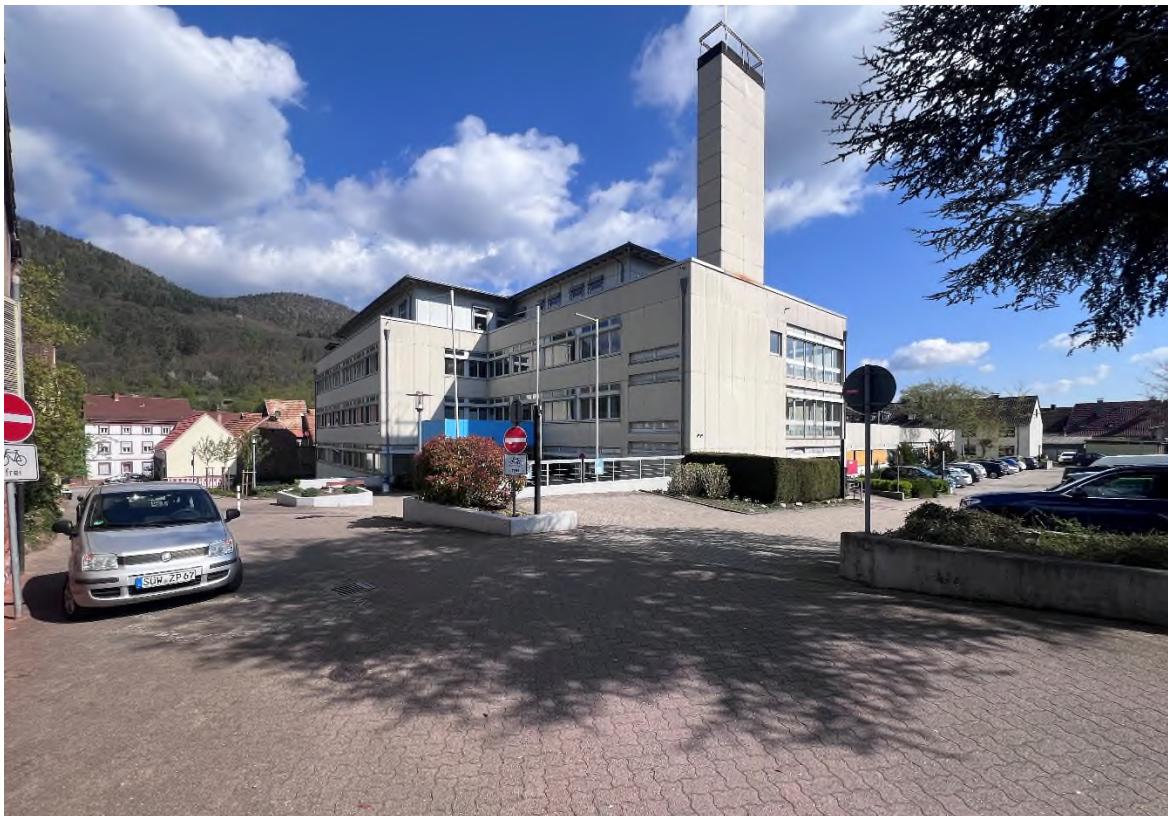
Bild 6: Blick von Süden (Flitschberg) auf die Zufahrt zum Parkplatz und auf die Bestandsgebäude der ehem. Klinik
