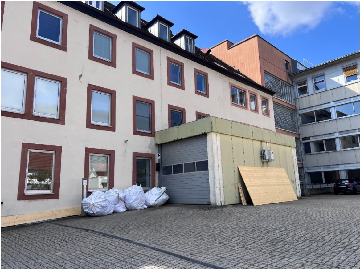
Bild 13: Blick von Nordosten auf die Bestandsgebäude der ehem. Klinik
