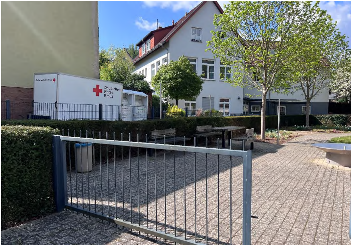
Bild 9: Blick auf die Zufahrt zum DRK von der Georg-Staab-Straße aus.
