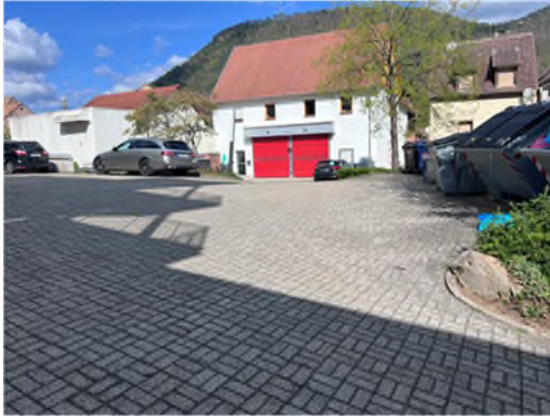
Bild 4: Blick auf die Zufahrt zur Rettungswache
