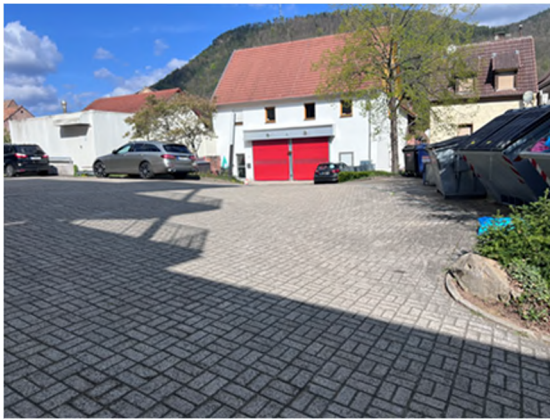
Bild 4: Blick auf die Zufahrt zur Rettungswache
