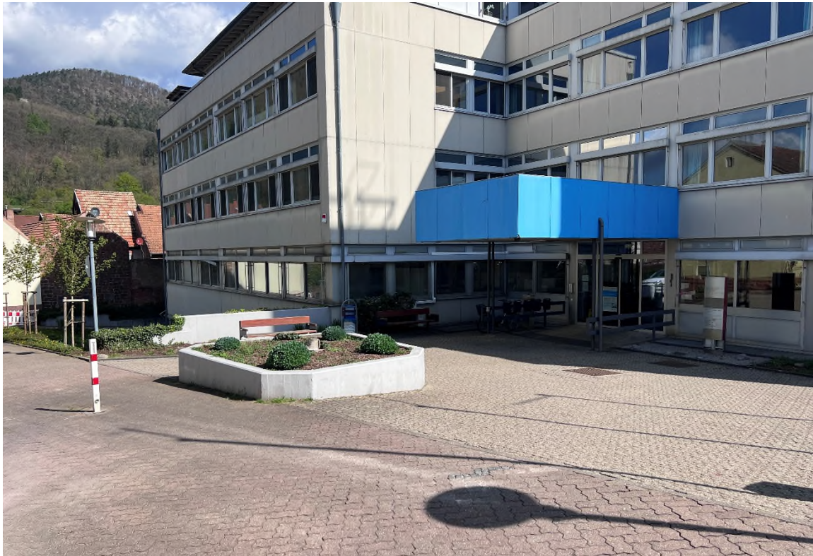
Bild 15: Blick von Südwesten auf die Bestandsgebäude der ehem. Klinik
