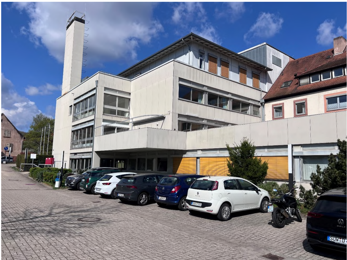
Bild 14: Blick von Südosten auf die Bestandsgebäude der ehem. Klinik
